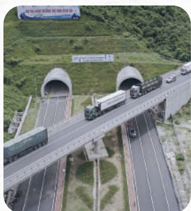
Dự án Hầm Đèo Cả
