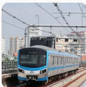
Dự án Metro Bến Thành - Suối Tiên
